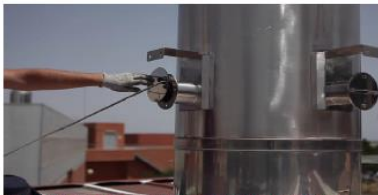
Fotografía última medición de gases contaminantes chimeneas HCUVA
