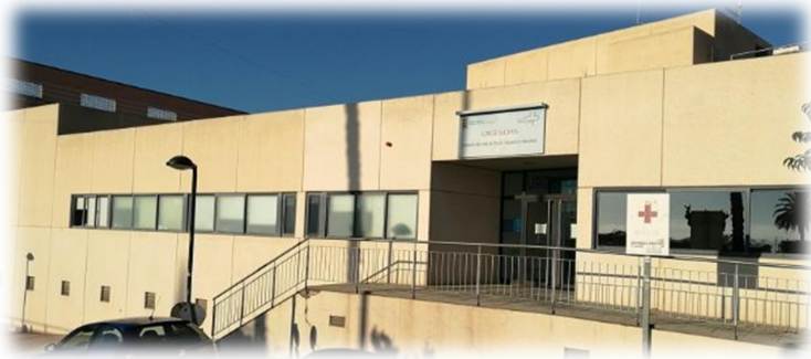
Figura 12: C.S Puerto Lumbreras. Fuente: C.S. Puerto Lumbreras
