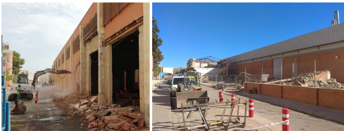
Imágenes demolición edificio antigua Central de Producción Térmica (2021)
